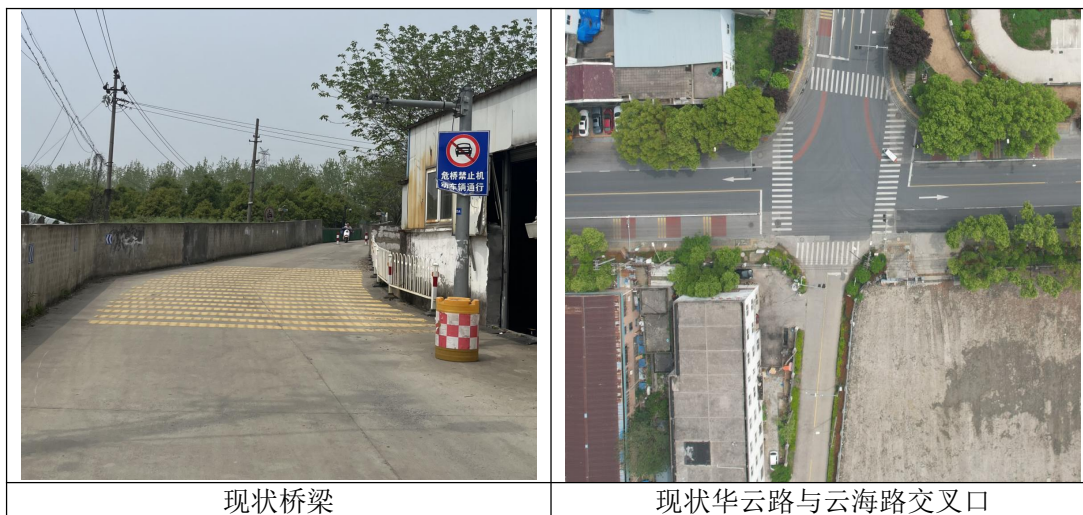
图 2-1 现状道路照片
