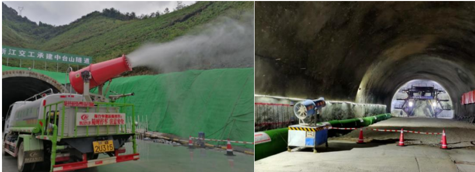
图 17 隧道洞口内外采用雾炮降尘等措施
