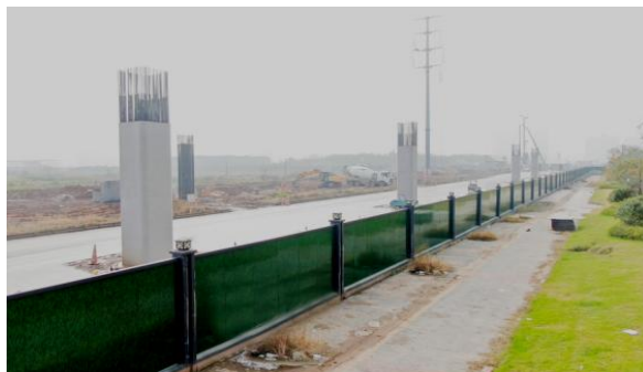
图 14 路面施工设围挡喷淋
