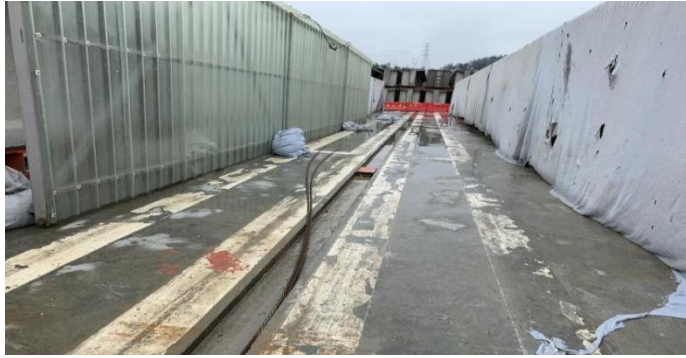
图 11 预制场设置排水边沟
