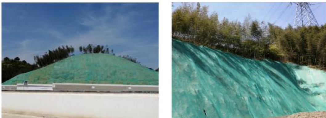
图 13 路基边坡防护
