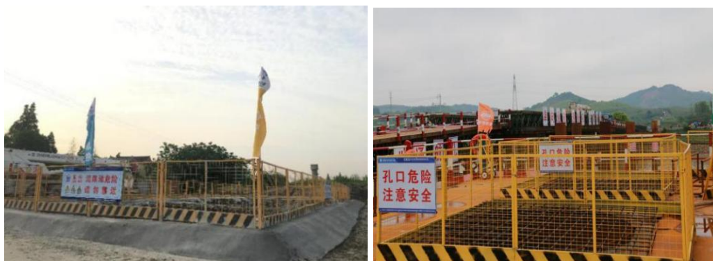
图 15 泥浆池防护、孔口防护图
